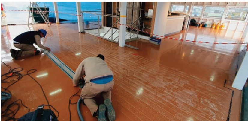
➤ Gracias a la técnica Purform utilizada en la instalación de la cubierta sintética en diversas zonas del ferry, se minimizan las emisiones de COV durante el proceso. El resultado obtenido en la aplicación de la gama Sika es de gran calidad y confort.
